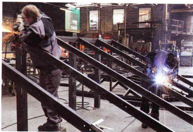
La première étape est la création du volume de la véranda par les ouvriers spécialisés. Après découpage aux dimensions, les barres en acier sont montées et soudées. Elles vont constituer la charpente.
